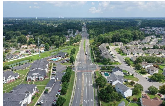
Widened Lynnhaven Pkwy
